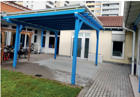
Mit Hilfe des Förderkreises konnte u.a. die Terrasse der Tagesförderstätte barrierefrei und mit Wetterschutz ausgebaut werden.
