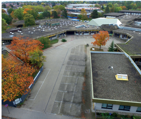
Das Kinderzentrum von oben mit dem Kooperationspartner Mosaikschule hinten rechts. Die Außenstellen und Fachdienste des Kiz sind nicht an diesem Standort. Vorne: Zufahrt von der Karl-Lochner-Straße
